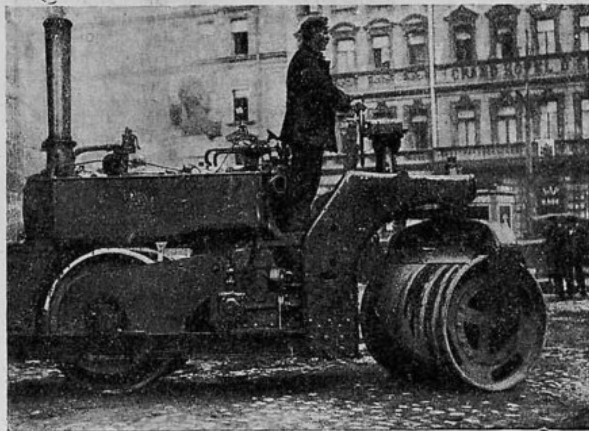
Паровой каток „Карльстонг“, укатывающий за 6 рабочих часов 8 км дороги. Двигатель машины работает на каменном угле
